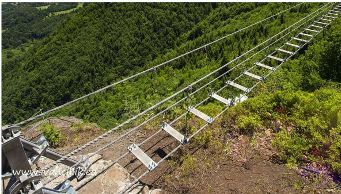
Εικόνα 8: γέφυρα τεσσάρων συρματόσχοινων θιβετιανού τύπου
